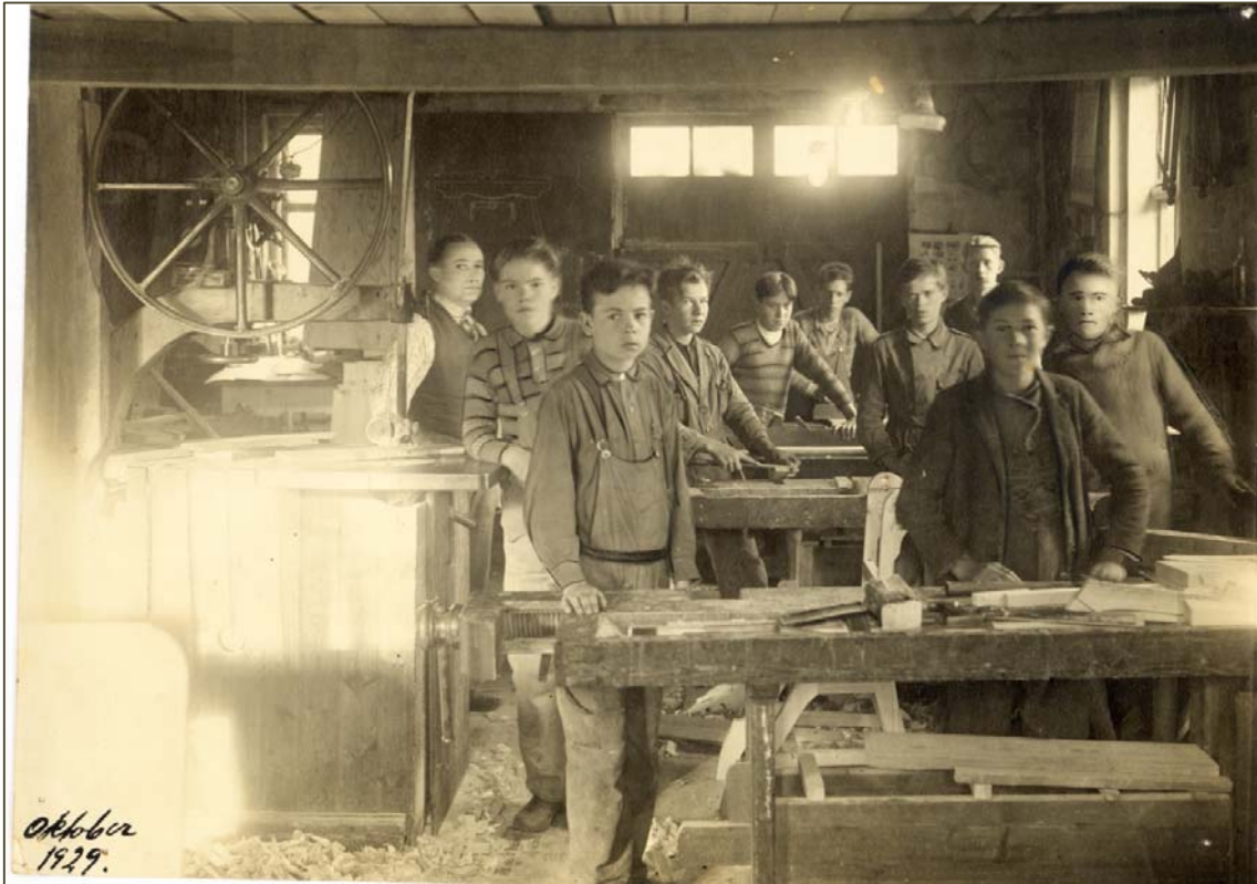
Opplæring av arbeidsledig ungdom. 1929. Askerød i bakgrunnen til venstre.
